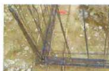
Nœud de chaînage : Continuité mécanique
